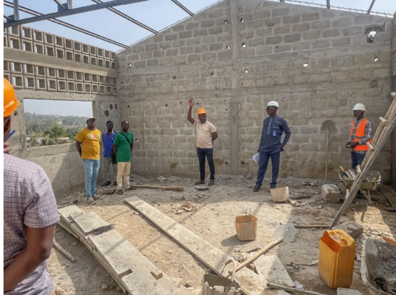
In Adjengré schreitet der Bau des Kindergartens voran
