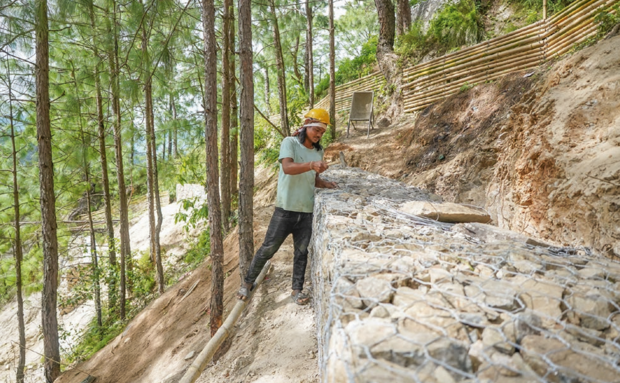
Schutzmauern schützen Gebäude vor Erdrutschen, die durch Erdbeben oder starke Regenfälle ausgelöst werden
