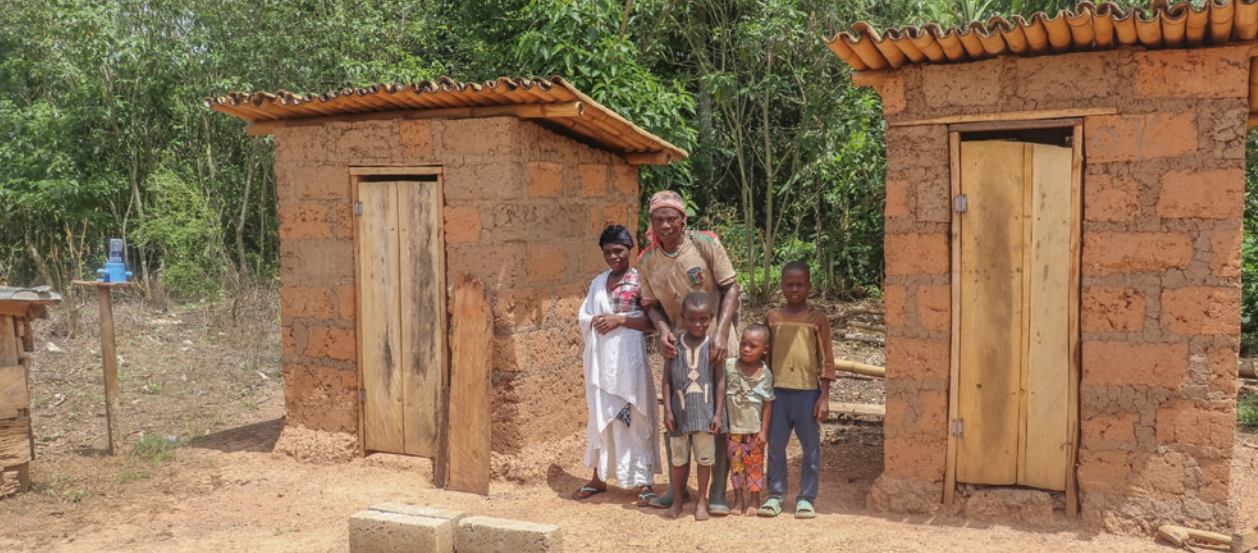
Mit zwei Säcken Zement, Bambus und Lehm hat Majidu zwei Toiletten für seine Familie gebaut
