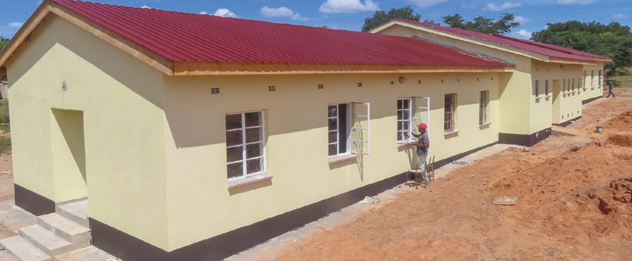
In Kadanya werden letzte Farbarbeiten am neuen Mädchenwohnheim vorgenommen
