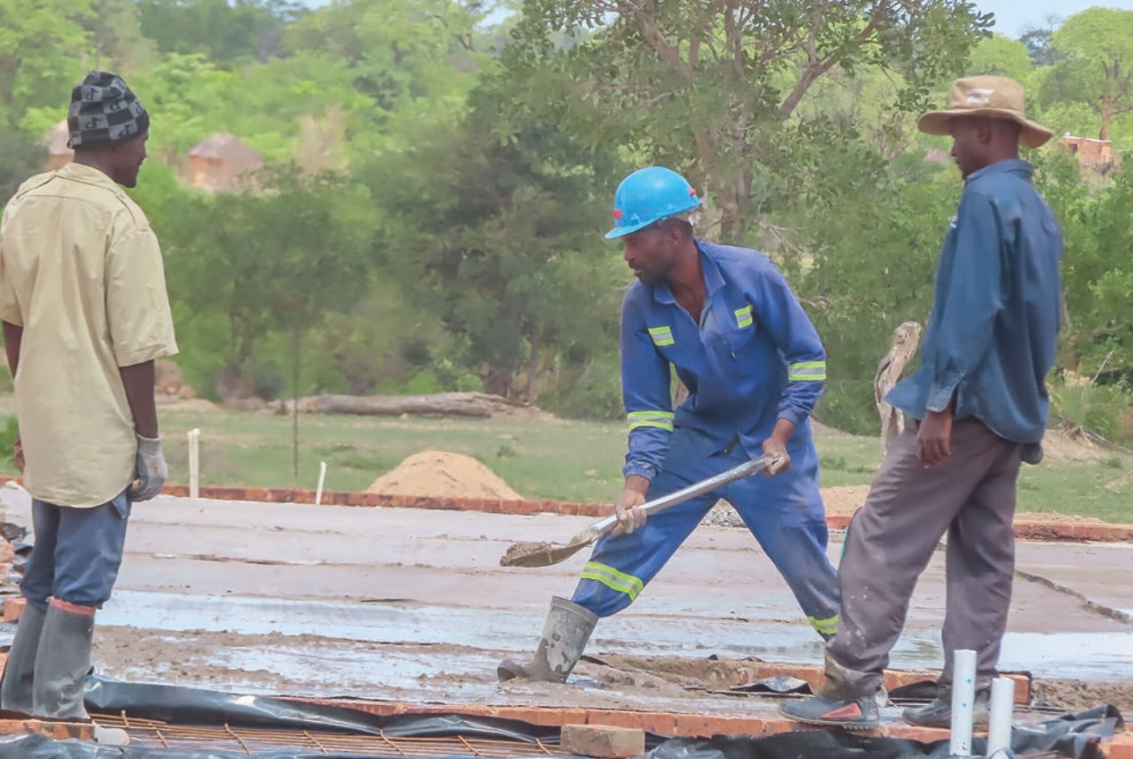
Das Fundament für die Mädchenwohnheime ist bereits fertig
