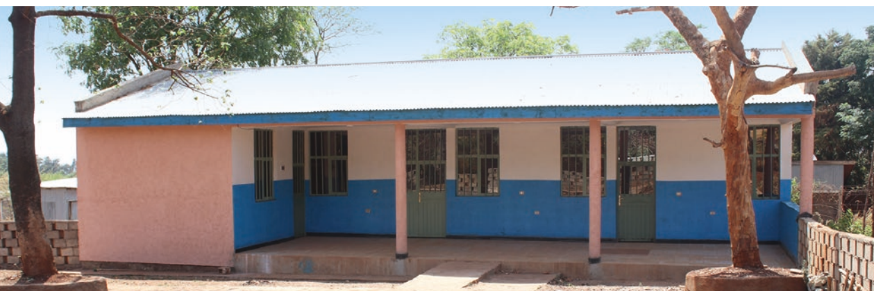
In Assosa wurde die Kindertagesstätte fertiggestellt
