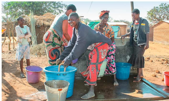
Damit die Gemeinden auch außerhalb der Regenzeit ausreichend Wasser zur Verfügung haben, sanieren wir 20 Brunnen und zwei Bewässerungssysteme.
