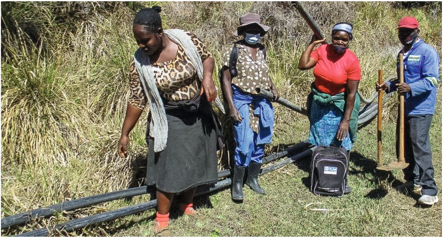
Wir unterstützten die Gemeindemitglieder bei der Installation von neuen Wasserleitungen.
