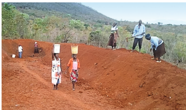
Der Bau von drei weiteren Fischteichen ist mittlerweile abgeschlossen.
