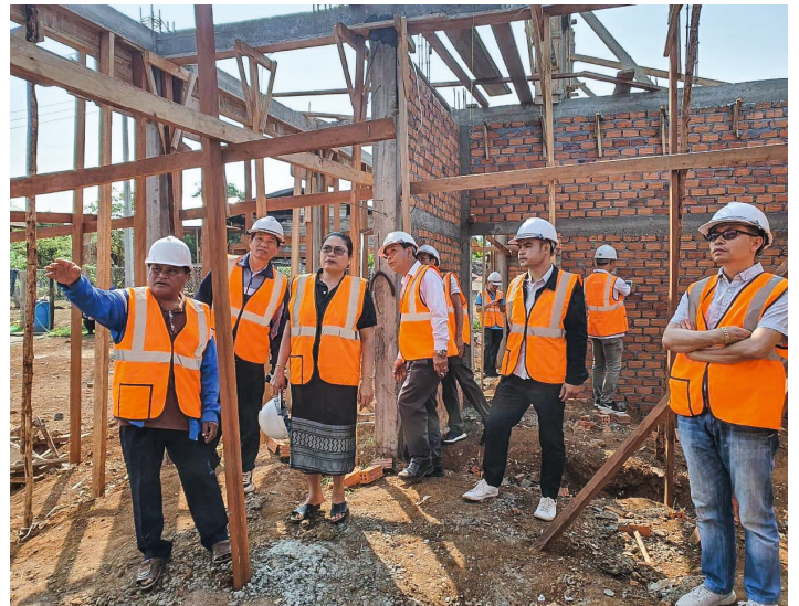
In regelmäßigen Kontrollbesuchen überprüft das Projektteam die Fortschritte im Bauprozess.
