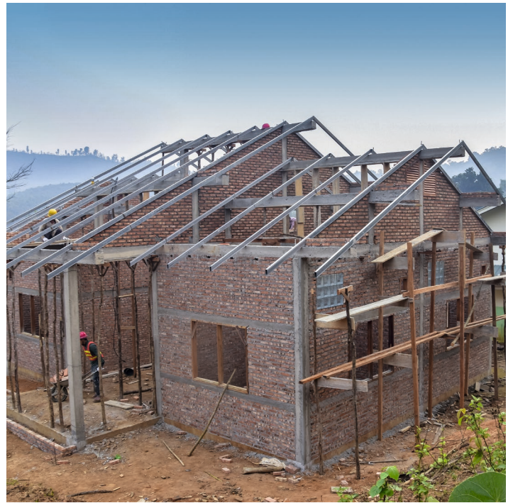
Die Bauarbeiten an dem Gesundheitszentrum in Salavan starteten im November 2020.
