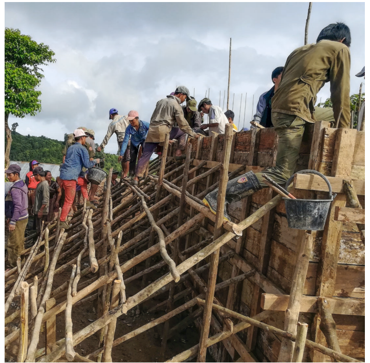
Gemeindemitglieder helfen beim Bau des Wasserspeichers in Phousone.
