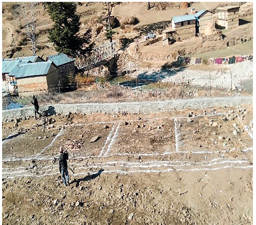
An der Pandavgufa Secondary School in Jumla soll ein neues Schulgebäude mit vier Klassenzimmern entstehen.
